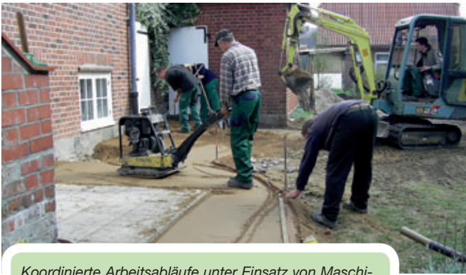
Koordinierte Arbeitsabläufe unter Einsatz von Maschinen ermöglichten die Realisierung der Schülerideen im Rahmen des Berufsschulunterrichtes.
