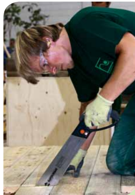
Jonas Rombach beim Bau der Brücke: Selbst die Holzarbeiten waren von Handarbeit geprägt.
