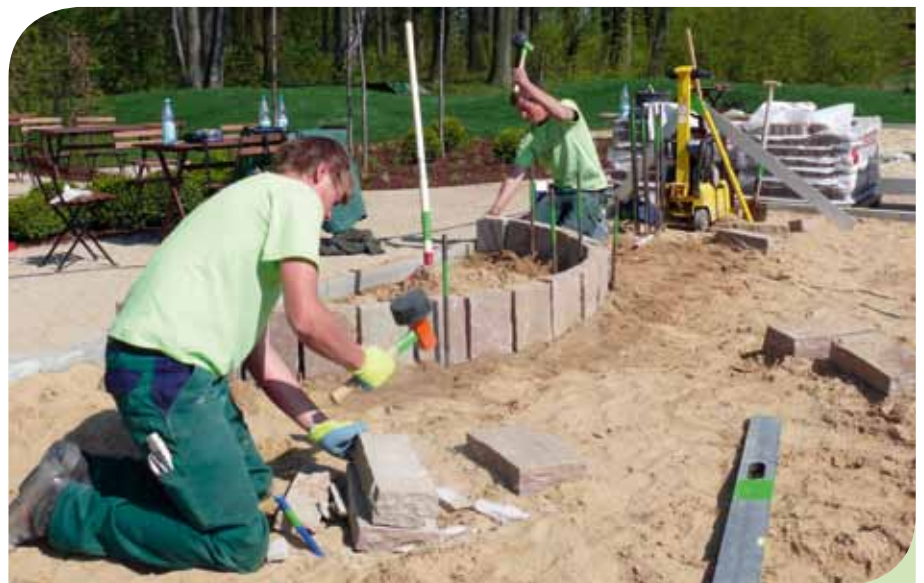
Auszubildende bauten auf der „Lernbaustelle“ während der Landesgartenschau in Bad Essen 13 temporäre Gärten – eine gelungene Kooperation zwischen Berufsschule und Ausbildungsbetrieben.
