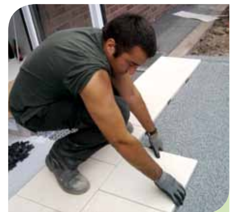
Statt wie in Frankreich in Sand werden Platten hierzulande in Splitt verlegt.
