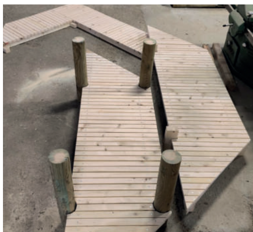
Beim Bau eines Holzverdecks kommt es nicht nur auf die perfekte Ablängen an, sondern auch auf ein einheitliches und in der Flucht befindliches Schraubenbild. (Foto: VGL Sachsen)
